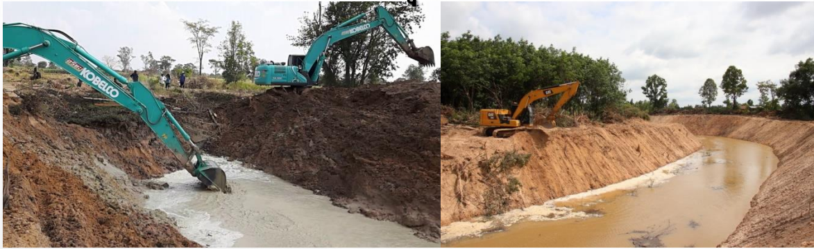
ก่อสร้างทางผ่านน้ำหรือขุดคลองสายใหม่
