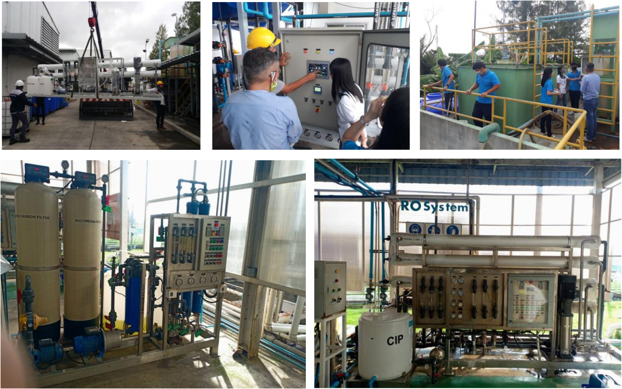
รูปที่ 4.23 การติดตั้ง RO membrane ของบริษัท ไทยนิปอนรับเบอร์ อินดัสตรี จำกัด (มหาชน)
