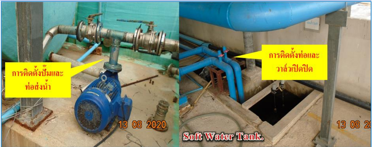
รูปที่ 4.29 การนำน้ำ condensate กลับมาใช้ซ้ำของบริษัท โมเดอร์น ไดस्टิลส์ แอนด์ พิคเมนท์ส จำกัด ภายใต้การดำเนินโครงการ
