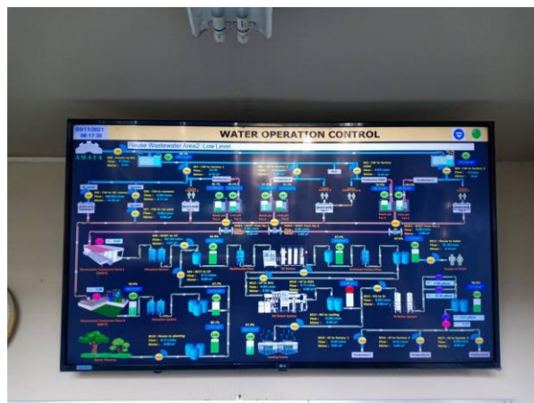
รูปที่ 4.12 การควบคุมอัตราการใช้น้ำแบบออนไลน์ของบริษัทไดกิน คอมเพรสเซอร์ อินดัสทรีส์ จำกัด ภายใต้การดำเนินโครงการ
