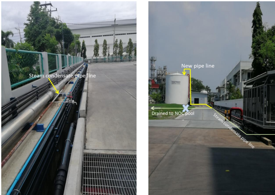
รูปที่ 4.70 เส้นทางเดินท่อเพื่อเก็บน้ำ steam condensate ของบริษัท ไลอ้อน (ประเทศไทย) จำกัด ภายใต้การดำเนินโครงการ
