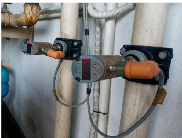
รูปที่ 4.12 การควบคุมอัตราการใช้น้ำแบบออนไลน์ของบริษัทไดกิน คอมเพรสเซอร์ อินดัสทรีส์ จำกัด ภายใต้การดำเนินโครงการ
