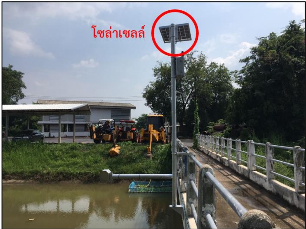
รูปที่ 4-4 ตำแหน่งการติดตั้งโซล่าเซลล์ ณ สถานีวัดระดับน้ำ
