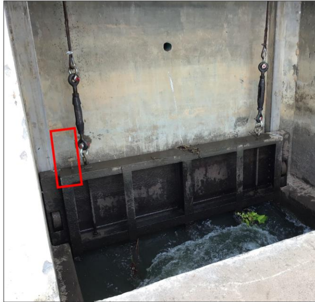
รูปที่ 2-3 ตำแหน่งที่ติดตั้งสายลวดสลิงสำหรับวัดระดับประตู
