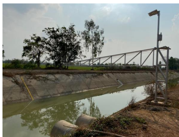
สถานีวัดระดับน้ำที่ 8 คลอง 1R-2L-MC กม.1+500 และจุดติดตั้ง Staff gauge
