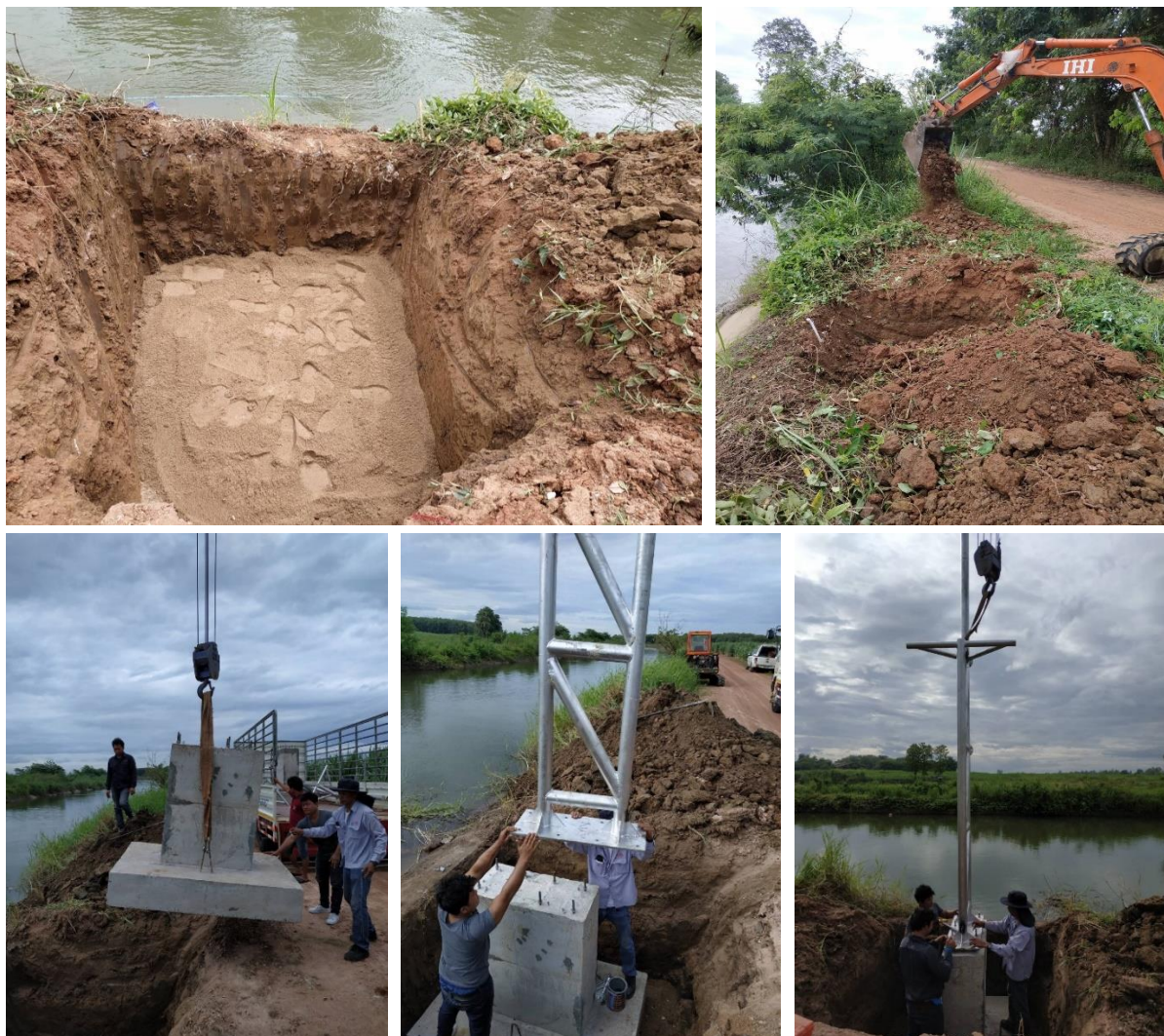
รูปที่ 4-20 ขั้นตอนการดำเนินงานขุดดินเพื่อลงโครงสร้างฐาน
