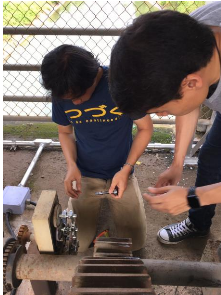
รูปที่ 3-14 ผลการติดตั้งเซ็นเซอร์วัดระดับประตูน้ำ
