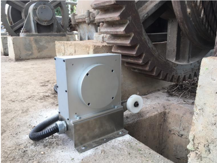
รูปที่ 3-14 ผลการติดตั้งเซ็นเซอร์วัดระดับประตูน้ำ
