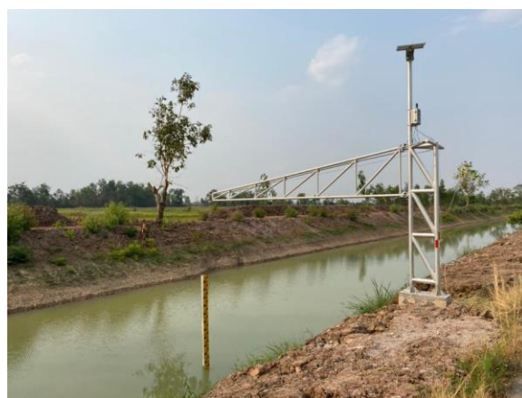
สถานีวัดระดับน้ำที่ 7 คลอง 2L-MC กม.16+500 และจุดติดตั้ง Staff gauge
