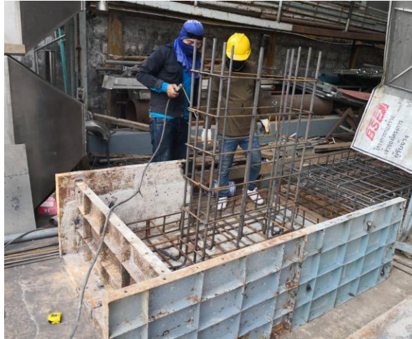
งานขึ้นแบบโครงสร้างฐาน
