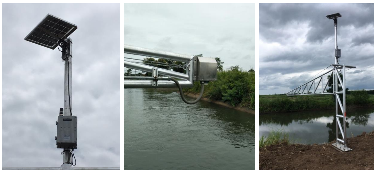
รูปที่ 4-21 งานติดตั้งอุปกรณ์ลงบนโครงสร้างและงานเดินท่อร้อยสายไฟ
