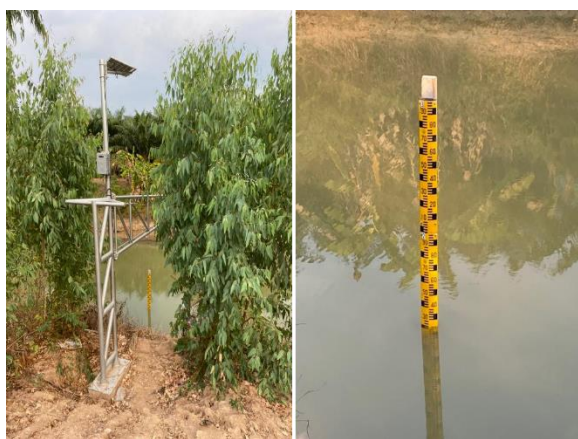
สถานีวัดระดับน้ำที่ 6 คลอง 1L-MC กม.17+800 และจุดติดตั้ง Staff gauge
