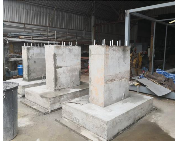
โครงสร้างฐานหลังจากเทคอนกรีตแล้ว
