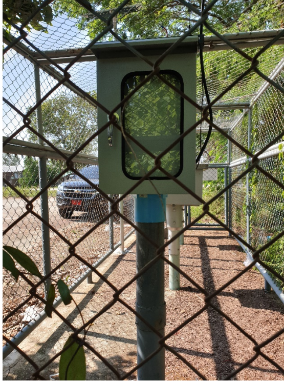
รูปที่ 6 ชุดตู้ควบคุมขนาด 35 x 52 x 25 เซนติเมตร
