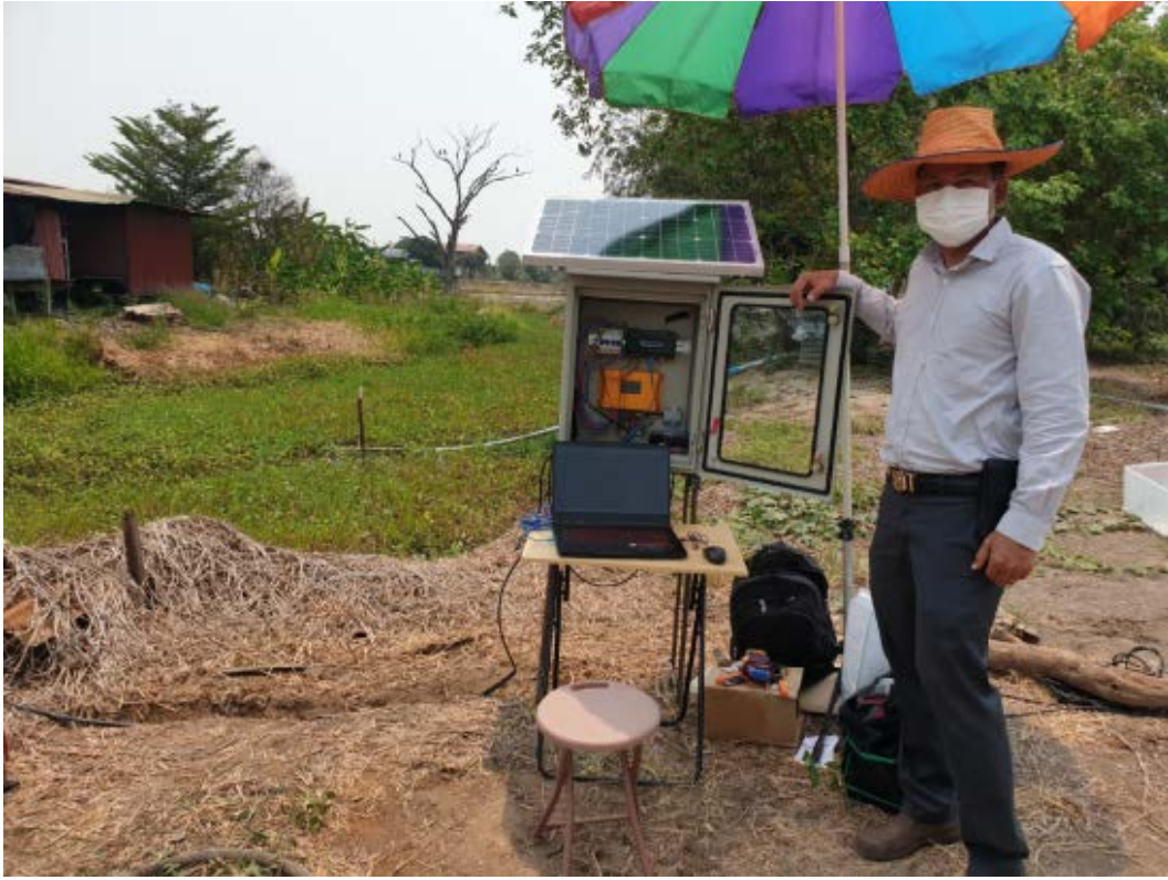
รูปที่ ข-4 ลงพื้นที่สำรวจตำแหน่งติดตั้งสถานีวัดระดับน้ำบาดาลในพื้นที่จังหวัดพระนครศรีอยุธยา
