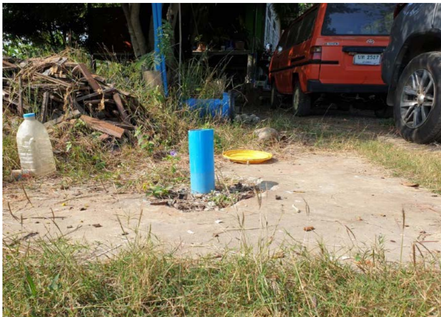
รูปที่ 5.2-19 ตำแหน่งการติดตั้งสถานีวัดระดับน้ำบาดาลที่ 3 ติดตั้งที่พิกัด 14.643451, 100.255009 ในแผนที่ Google Map และสภาพก่อนการติดตั้งเครื่องวัดระดับน้ำบาดาล
