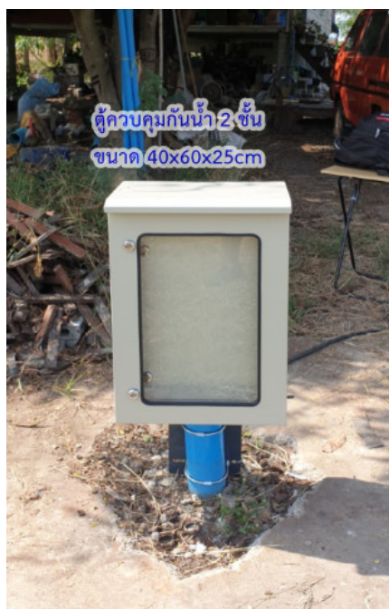
รูปที่ 5.2-11 ชุดตู้ควบคุมขนาด 40x60x25 เซนติเมตร
