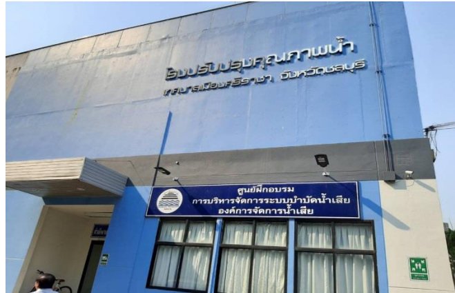
รูปที่ 2.23 ด้านหน้าโรงบำบัดน้ำเสีย
