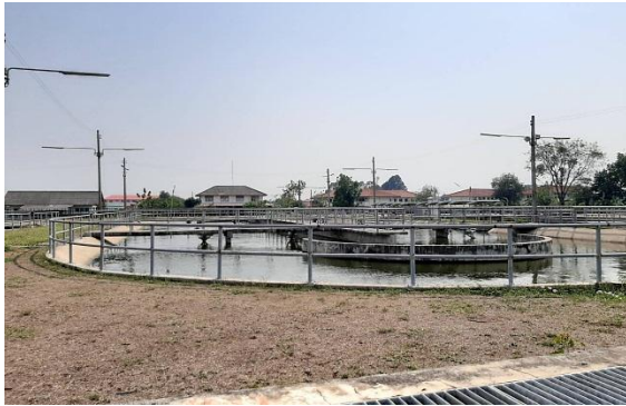
รูปที่ 2.18 ระบบบำบัดน้ำเสียแบบคลองวนเวียน
