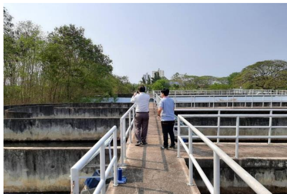
รูปที่ 2.85 บ่อเติมอากาศแบบคลองวนเวียน
