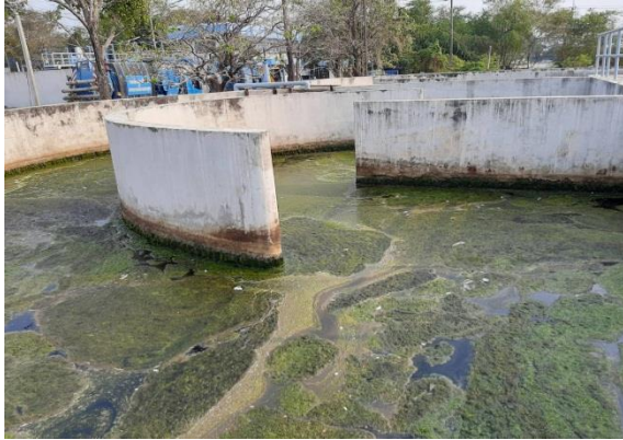
รูปที่ 2.61 บ่อเติมอากาศแบบคลองวงเวียน
