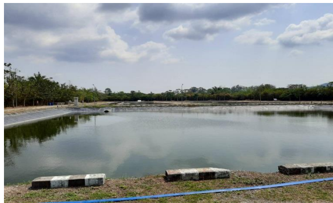
รูปที่ 2.40 บ่อพักน้ำใส
