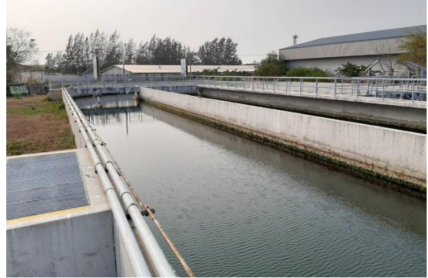
รูปที่ 2.61 บ่อเติมอากาศแบบคลองวงเวียน
