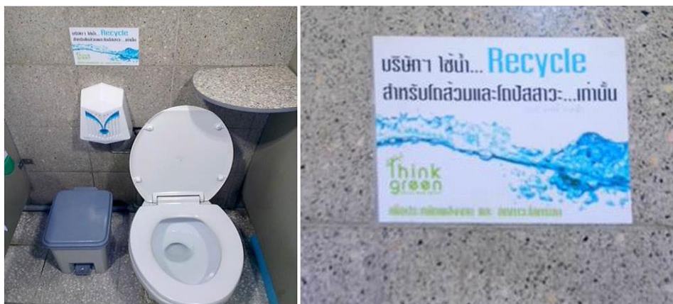
รูปที่ 4.1 การใช้น้ำ recycle เป็นน้ำกดชักโครก
