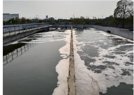
รูปที่ 2.53 บ่อเติมอากาศแบบคลองวงเวียน
