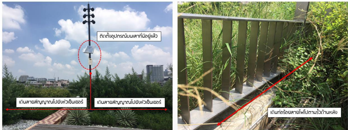
รูปที่ 4.1-4 แสดงจุดติดตั้งอุปกรณ์ตรวจจับ สถานีที่ 2 บริเวณสวนลอย สวน 100 ปีฯ
