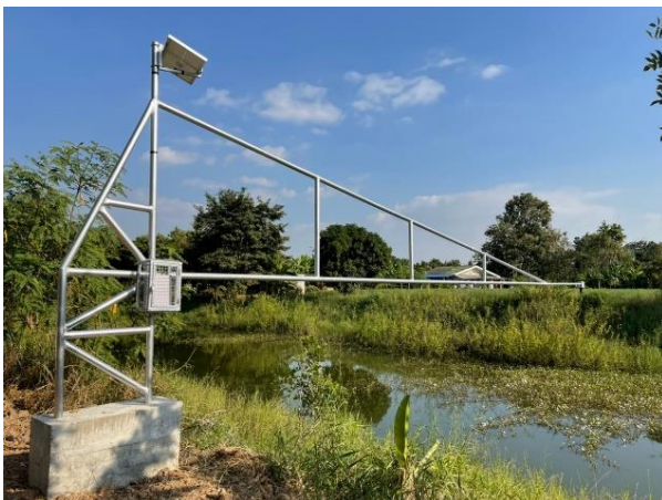
คลอง 3L-MC (มาบไทร) ต.ช่องลม อ.ลานกระบือ พิกัด 16.5581 99.92012
