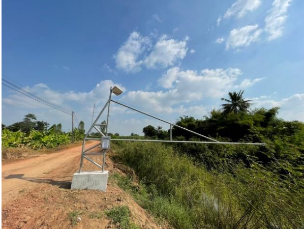
คลอง 1L-1R-2L-MC (แม่พาย) ต.โนนพลวง อ.ลานกระบือ พิกัด 16.56388 99.851750
