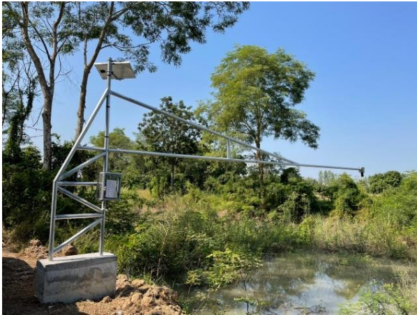
คลอง 2R-1R-2L-MC (แม่ฝายสายล่าง) ต.หนองหลวง อ.ลานกระบือ พิกัด 16.67851 99.82625
