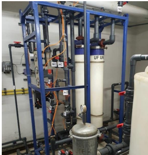
รูปที่ 4-37 แสดงระบบกรอง ULTRAFILTRATION
