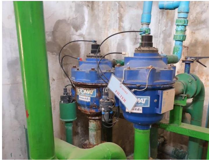
รูปที่ 4-51 แสดงตัวกรอง (FILTER) ในส่วนระบบ Water Reuse
