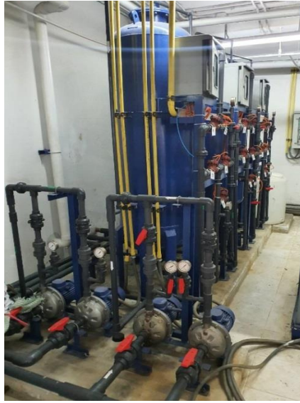
รูปที่ 4-36 แสดงถึงกรองทรายและกรองคาร์บอน
