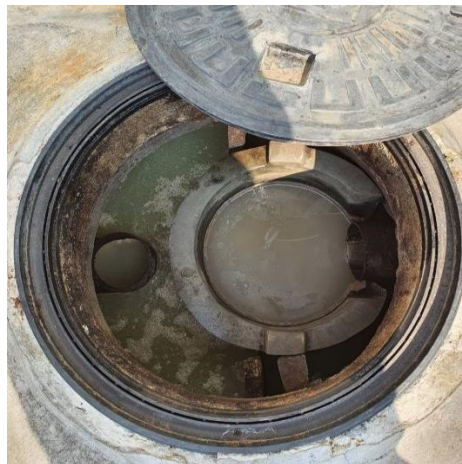
รูปที่ 4-40 แสดงถังดักไขมัน (Grease Trap)
