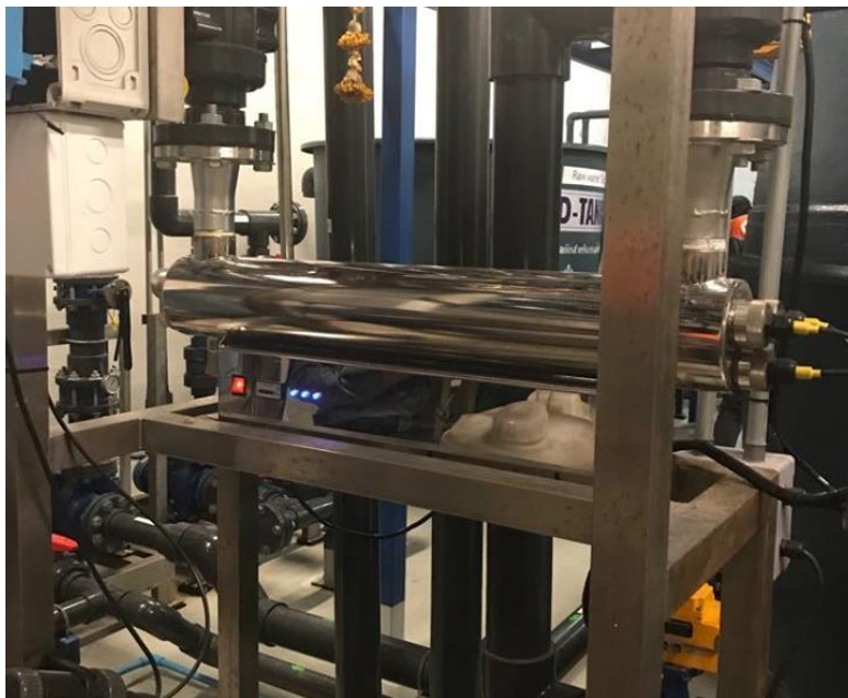
รูปที่ 4-62 แสดงการฆ่าเชื้อด้วยระบบ UV
