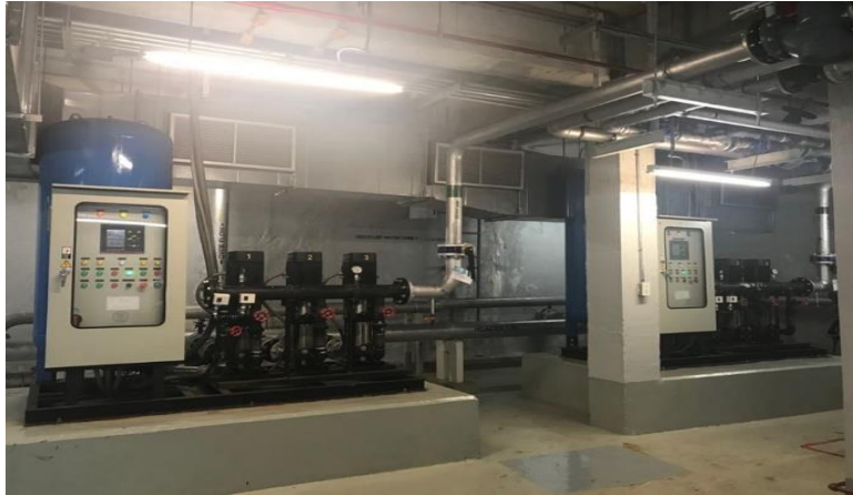
รูปที่ 4-63 แสดงระบบ transfer water reuse
