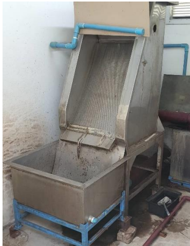
รูปที่ 4-42 แสดงการกรองละเอียด (Fine Screen)
