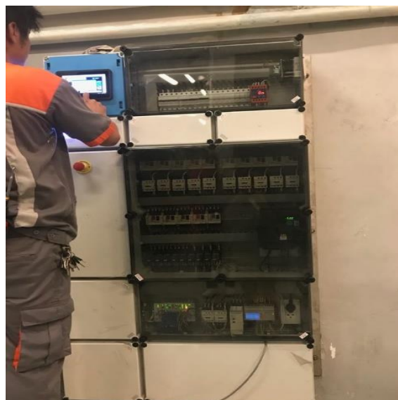
รูปที่ 4-65 แสดงส่วนของการควบคุมการดำเนินการระบบบำบัด water reuse
