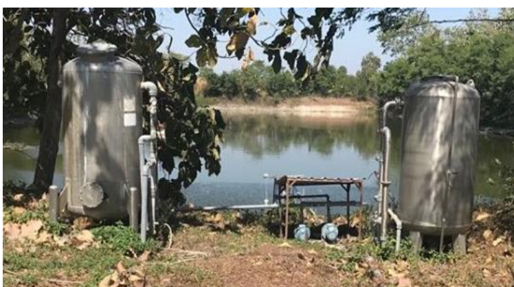
รูปที่ 4-68 แสดงถึงกรองทรายทำหน้าที่กรองน้ำผิวดินก่อนเติมโอโซน
