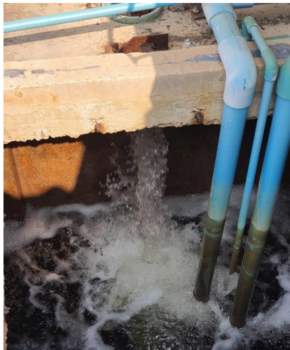
รูปที่ 4-50 แสดงบ่อเติมอากาศแบบ SBR
