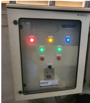
รูปที่ 4-54 แสดงเครื่องผลิตโอโซนในส่วนระบบ Water Reuse
