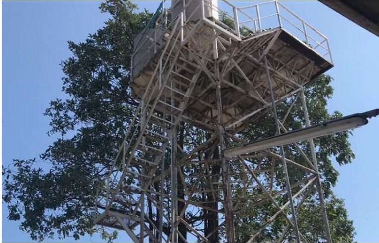
รูปที่ 4-70 แสดงแท่นและถังเก็บที่ผ่านการบำบัดสำหรับเป็นน้ำประปา
