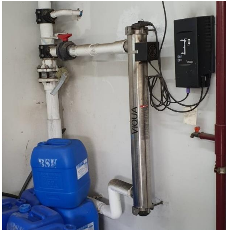
รูปที่ 4-46 แสดงระบบ Ultraviolet Radiation (UV) สำหรับฆ่าเชื้อโรค
