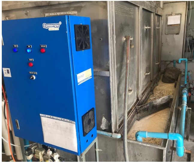
รูปที่ 4-73 แสดงการนำโอโซนแยกจากน้ำเสียบูทฟนีส
