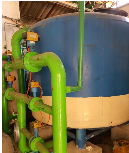
รูปที่ 4-52 แสดงถังกรองทรายและคาร์บอนในส่วนระบบ Water Reuse
