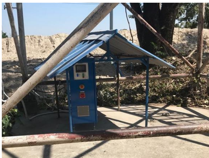
รูปที่ 4-69 แสดงเครื่องผลิตโอโซนสำหรับบำบัดน้ำผิวดินเป็นน้ำประปา
