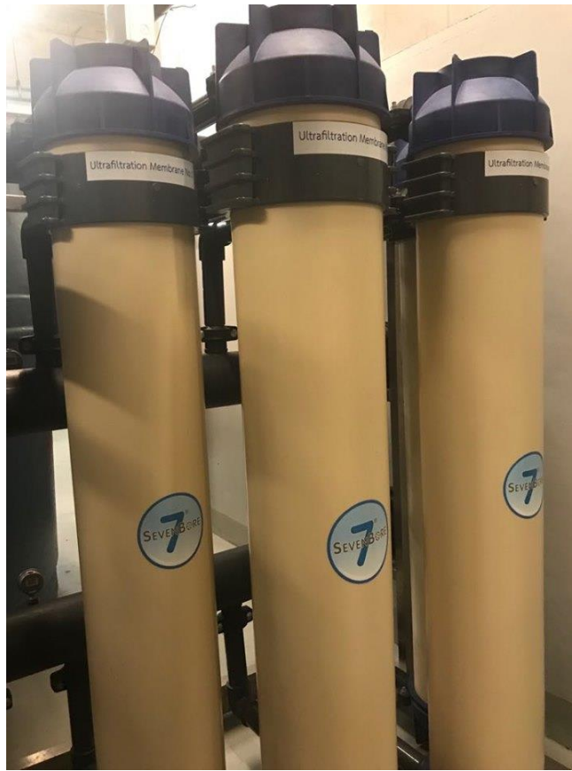
รูปที่ 4-61 แสดง Ultrafiltration Membrane
