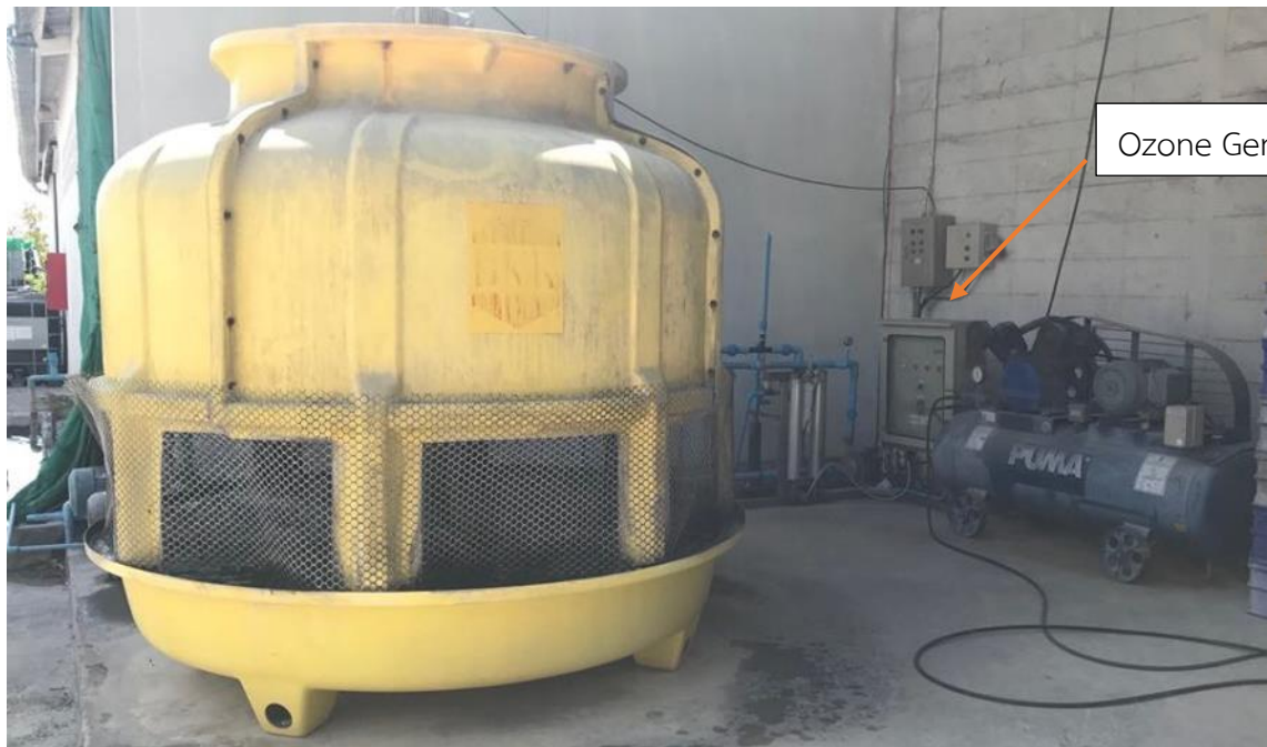
รูปที่ 4-71 แสดงระบบ Cooling Tower โดยใช้โอโซน
