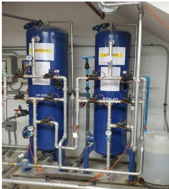
รูปที่ 4-34 แสดงตัวกรองทราย และการแลกเปลี่ยนไอออนในระบบ Water Reuse สำหรับ Cooling Tower
