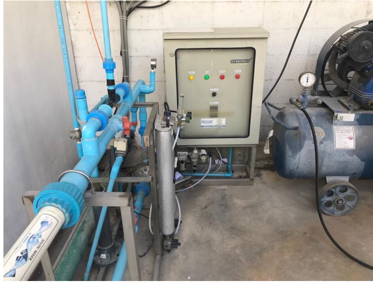
รูปที่ 4-72 แสดงเครื่องโอโซนสำหรับระบบ Cooling Tower
