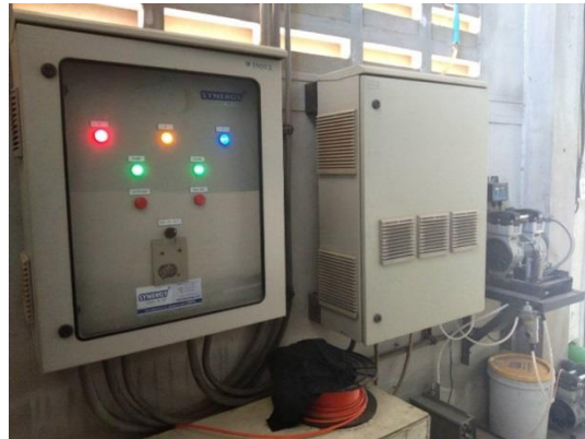
รูปที่ 4-54 แสดงเครื่องผลิตโอโซนในส่วนระบบ Water Reuse
