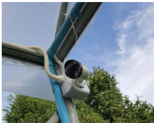
ภาพที่ 2.1.2-1 การติดตั้งกล้องวงจรปิด
