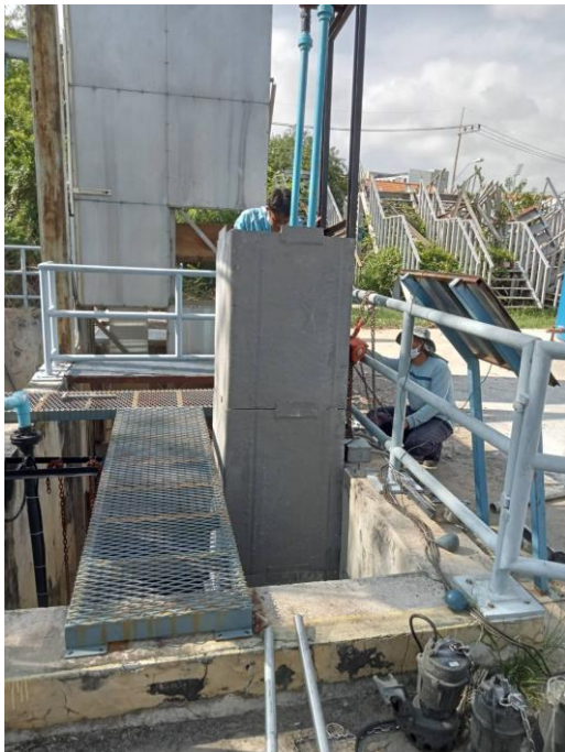
ภาพที่ 2.2-4 การติดตั้งตะแกรงกรองขยะเพิ่มขึ้นหลังตะแกรงของสถานีสูบน้ำเสีย
