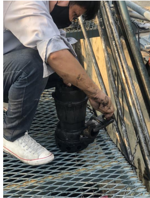
ภาพที่ 2.2-3 การปรับแก้ชุดตีนเป็ด
