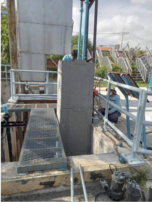
ภาพที่ 3.2.1-4 การติดตั้งตะแกรงกรองขยะเพิ่มขึ้นหลังตะแกรงของสถานีสูบน้ำเสีย
