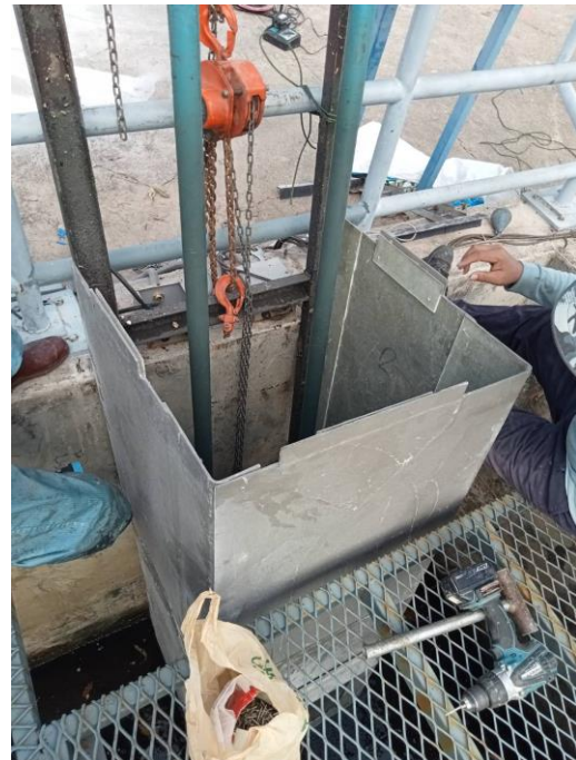
ภาพที่ 2.2-4 การติดตั้งตะแกรงกรองขยะเพิ่มขึ้นหลังตะแกรงของสถานีสูบน้ำเสีย
