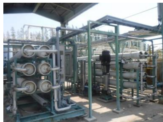
รูปที่ 3-88 การปรับปรุงความสามารถของระบบ RO ของบริษัท พีทีที โกลบอล เคมิคอล จำกัด (มหาชน) สาขา 12
