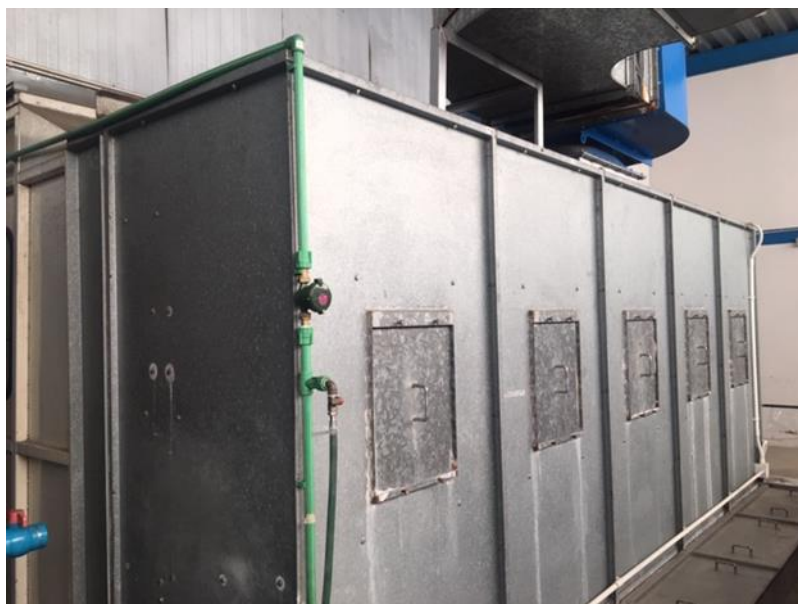
รูปที่ 3-130 ลักษณะการติดตั้งมิเตอร์น้ำ ห้องฟอสส์ ของบริษัท ไทยควิwickเทคโนโลยี จำกัด
