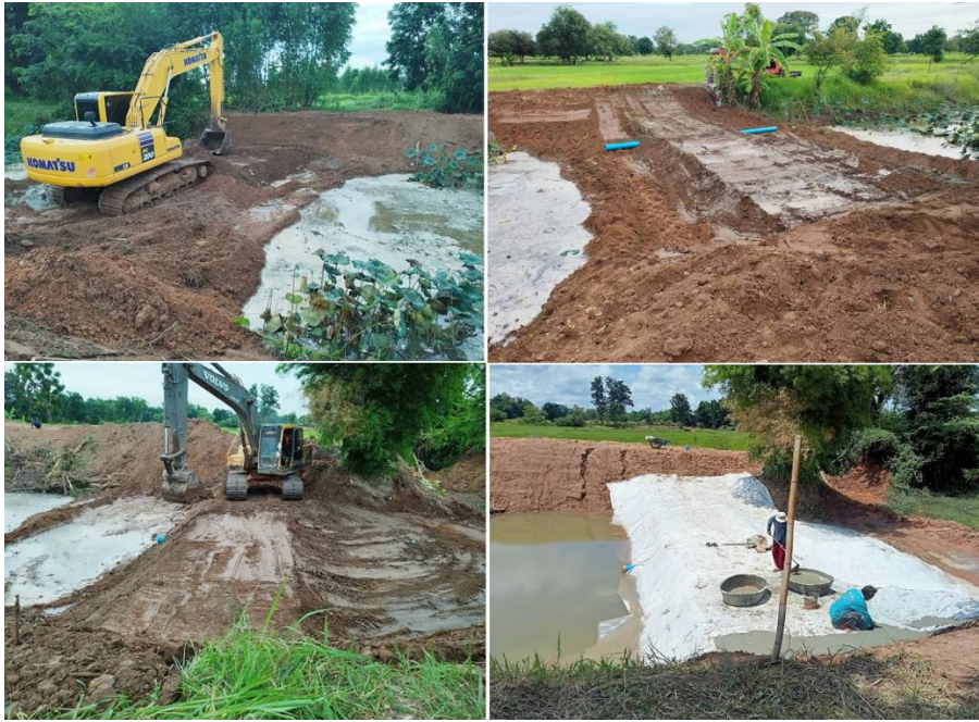
รูปที่ 2-5 ขั้นตอนการสร้างฝายแบบชั่วคราว ที่มา ศูนย์ปฏิบัติการภัยแล้ง
